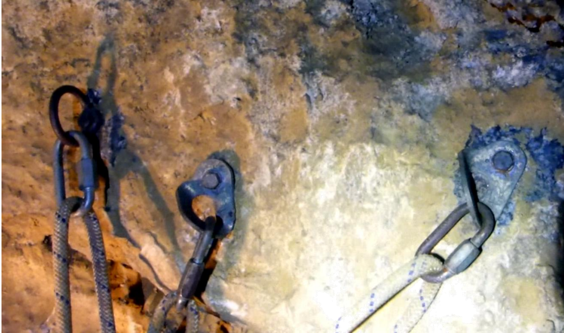
Anclajes viejos y oxidados en la cabecera del pozo de 45m (#4)
