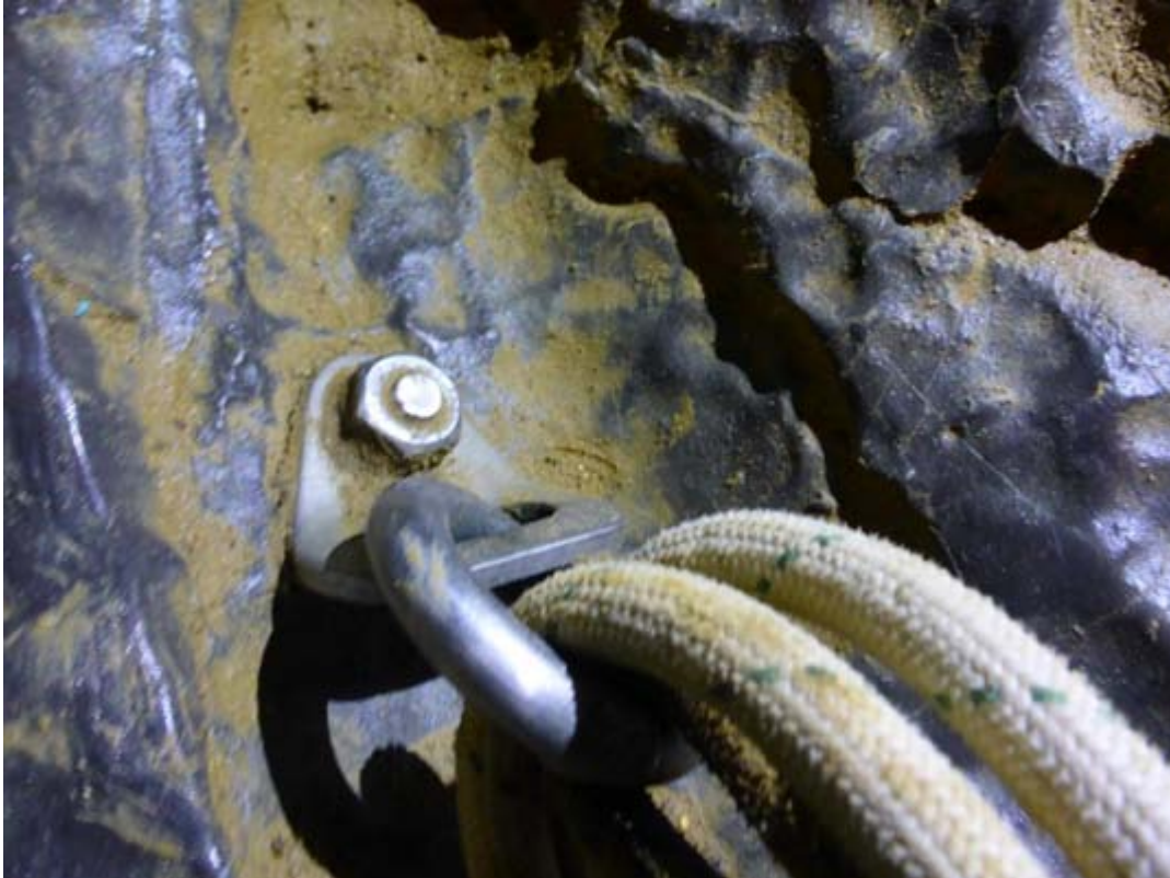
Esparrago que apenas asoma ¿Cuántos filetes de rosca útil usa? En la subida después de la gatera vertical (#8)
